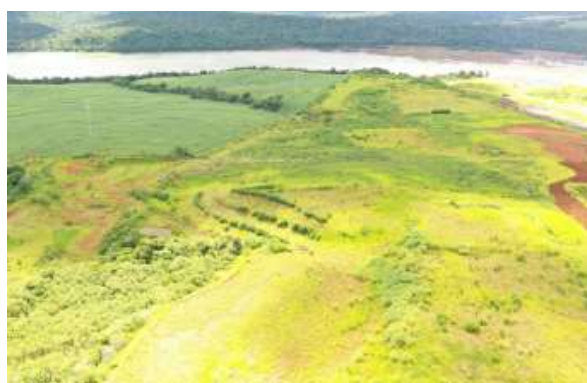
Canteiro de obras – ME - Julho 2020.
