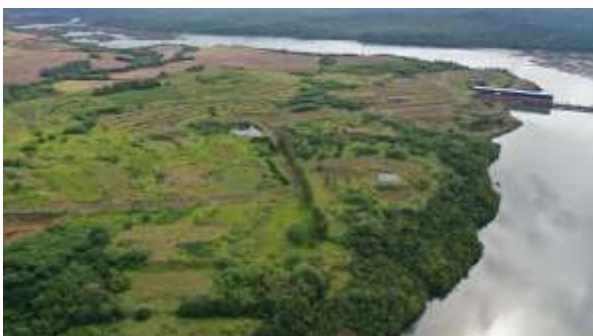
Canteiro de obras – ME - Setembro 2021.
