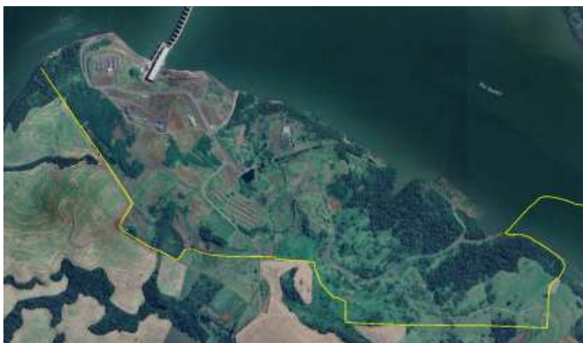
Canteiro de obras, janeiro/24.
