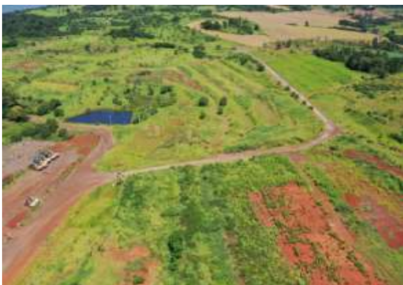
Canteiro de obras – ME - Janeiro 2021.
