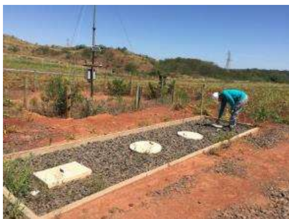
Amostragem do efluente da ETE da casa de força.
