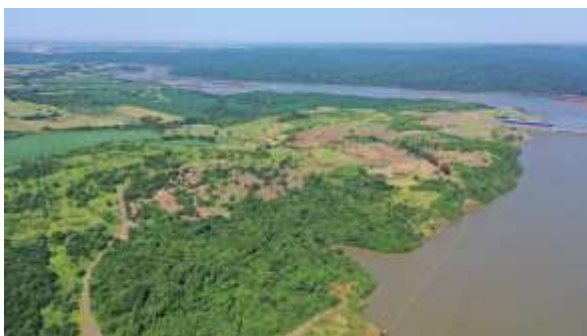
Canteiro de obras – ME - Janeiro 2024.
