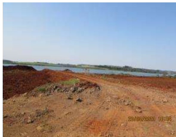
Início da remoção dos taludes das lagoas.
