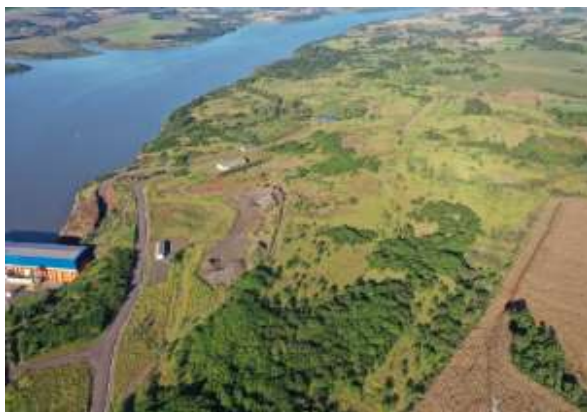
Canteiro de obras – ME - Julho 2022.
