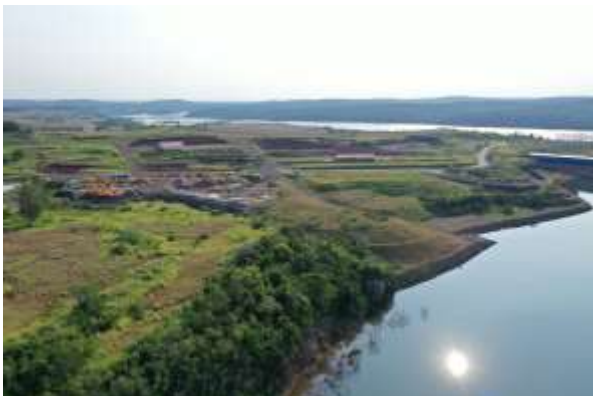
Canteiro de obras – MD - Julho 2019.
