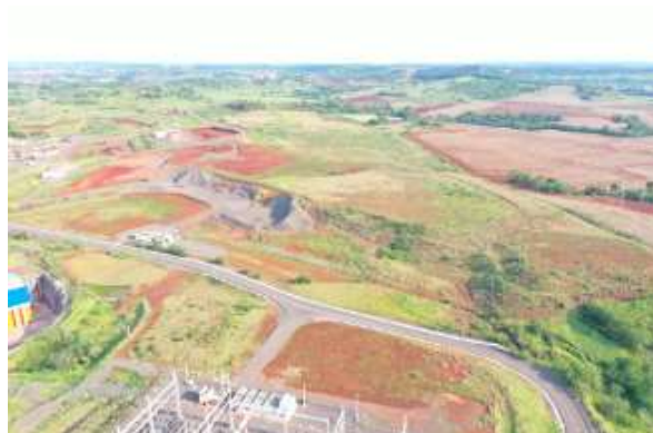
Canteiro de obras – ME - Novembro 2019.
