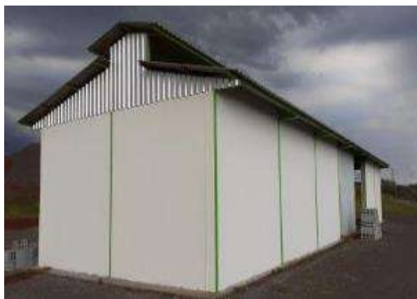
Depósito de Óleo e Resíduos (DOR).
