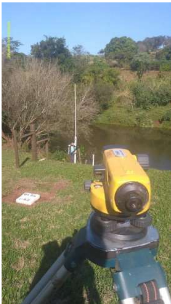
Nivelamento realizado na Estação UHE Baixo Iguaçu Rio Andrada – 19/05/2020.
