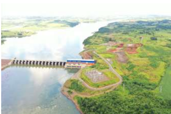
Canteiro de obras – ME – Janeiro 2020.
