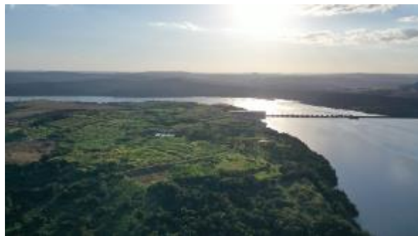
Canteiro de obras – ME - Junho 2024.
