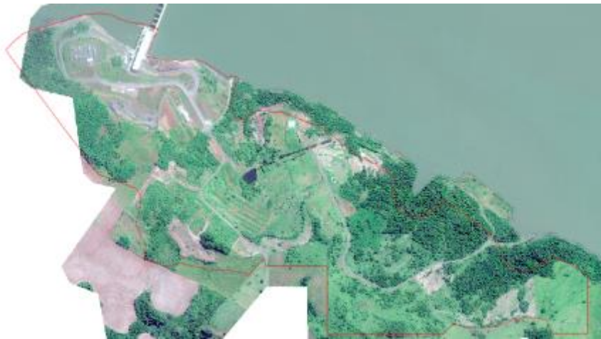
Canteiro de obras, setembro/24.
