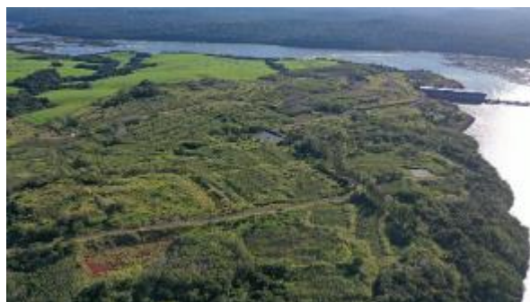
Canteiro de obras – ME - Junho 2025.
