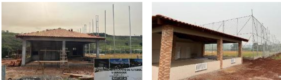
Figura 4.28.2-3. Evidências fotográficas da construção do campo de futebol e quiosque.
