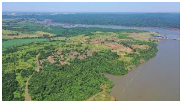
Canteiro de obras – ME - Janeiro 2024.
