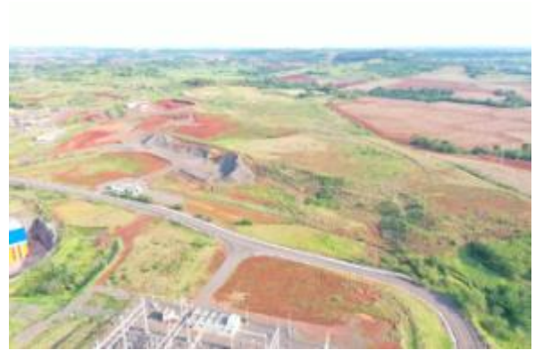
Canteiro de obras – ME - Novembro 2019.
