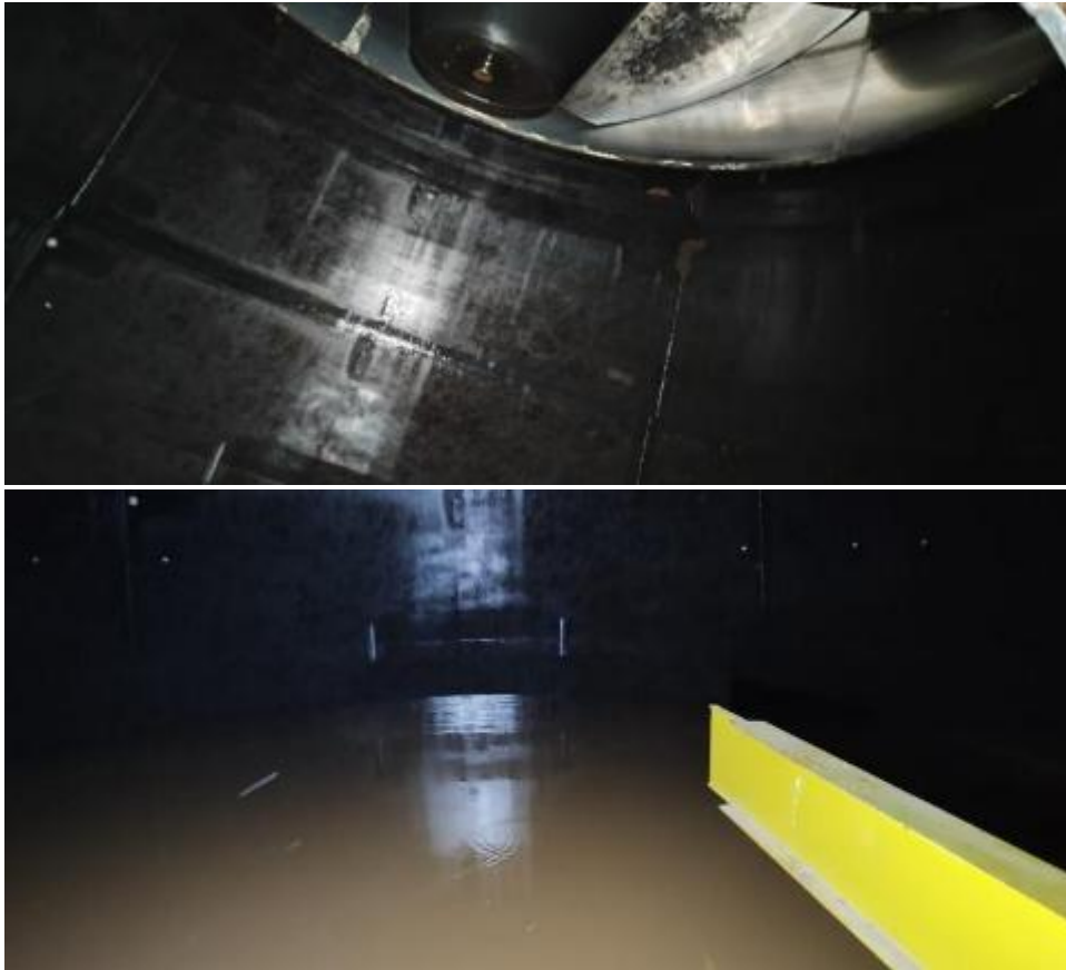
Figura 4.16.2-8. Vista do kaplan abertura da escotilha de acesso ao tubo para montagem da plataforma de manutenção.
