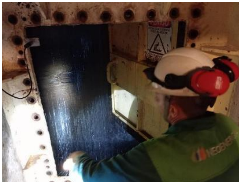
Figura 4.16.2-9. Abertura da escotilha da caixa espiral inspeção no ralo da caixa espiral.
