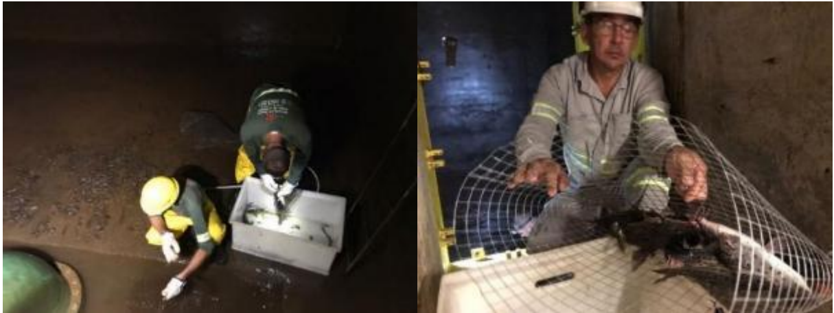
Figura 4.16.-11. Resgate poço de esgotamento
