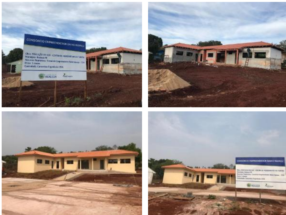
Figura 4.28.2-2. Evidências fotográficas da reforma e construção do CAT.
