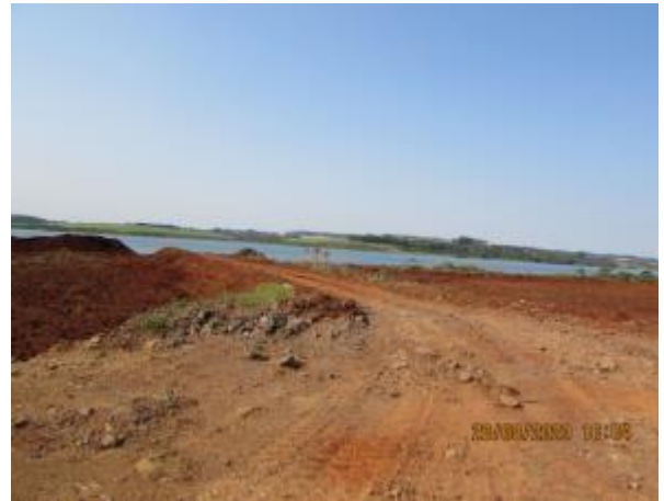
Início da remoção dos taludes das lagoas.
