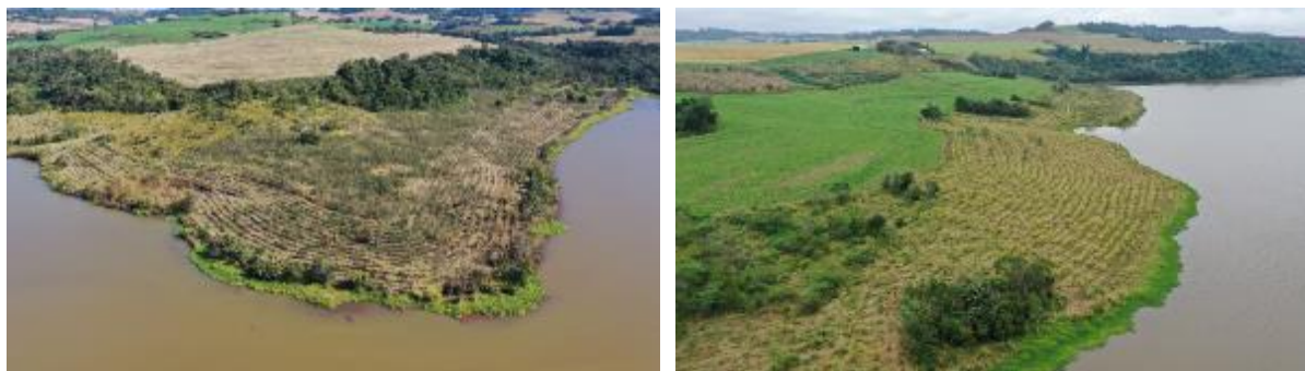
Figura 4.6.2-8. Registros fotográficos das atividades realizadas para recomposição vegetal da APP e canteiro de obras.
