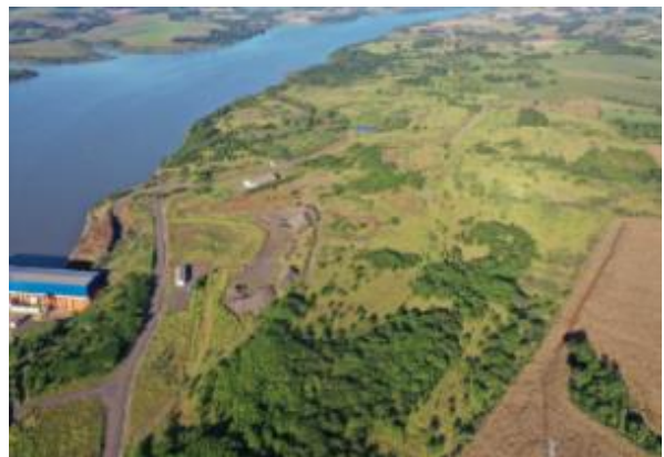
Canteiro de obras – ME - Julho 2022.
