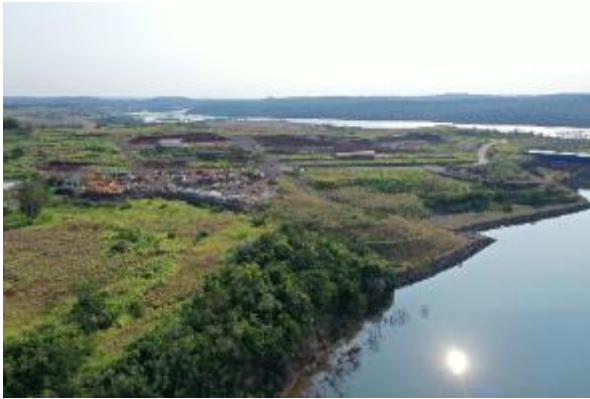
Canteiro de obras – MD - Julho 2019.
