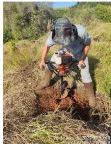
Coveamento semi mecanizado.
