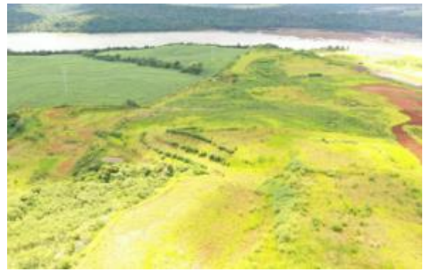
Canteiro de obras – ME - Julho 2020.
