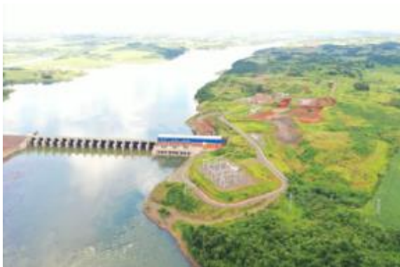
Canteiro de obras – ME – Janeiro 2020.
