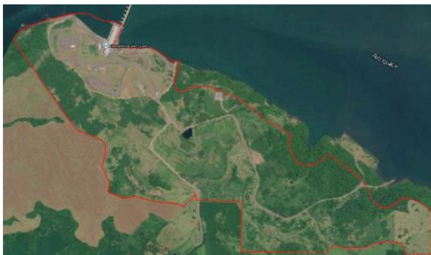
Canteiro de obras, dezembro/25.
