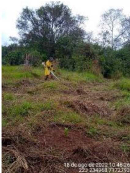
Roçada sendo realizada.
