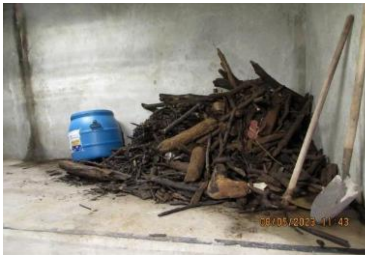
Figura 4.16.2-5. Resíduos proveniente do reservatório retirado do ralo de esgotamento da caixa espiral
