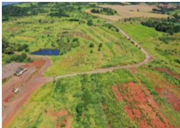
Canteiro de obras – ME - Janeiro 2021.
