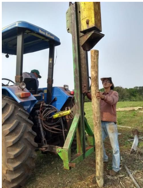
Treinamento com equipamento bate estacas.
