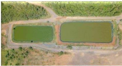
Estação de Tratamento de Efluentes – ETE (ME) 2019.
