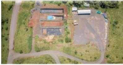
Durante a construção aterro sanitário da UHE
