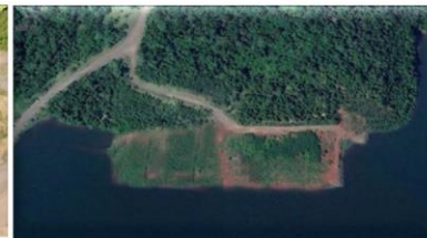
Estação de Tratamento de Efluentes – ETE (ME) 2022.
