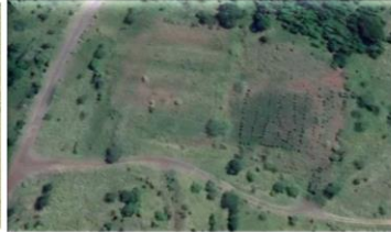
Desmobilização e aplicação do PRAD na área do aterro sanitário da UHE
