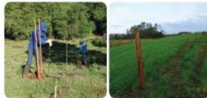
Cercamento da APP Cerca Concluída
